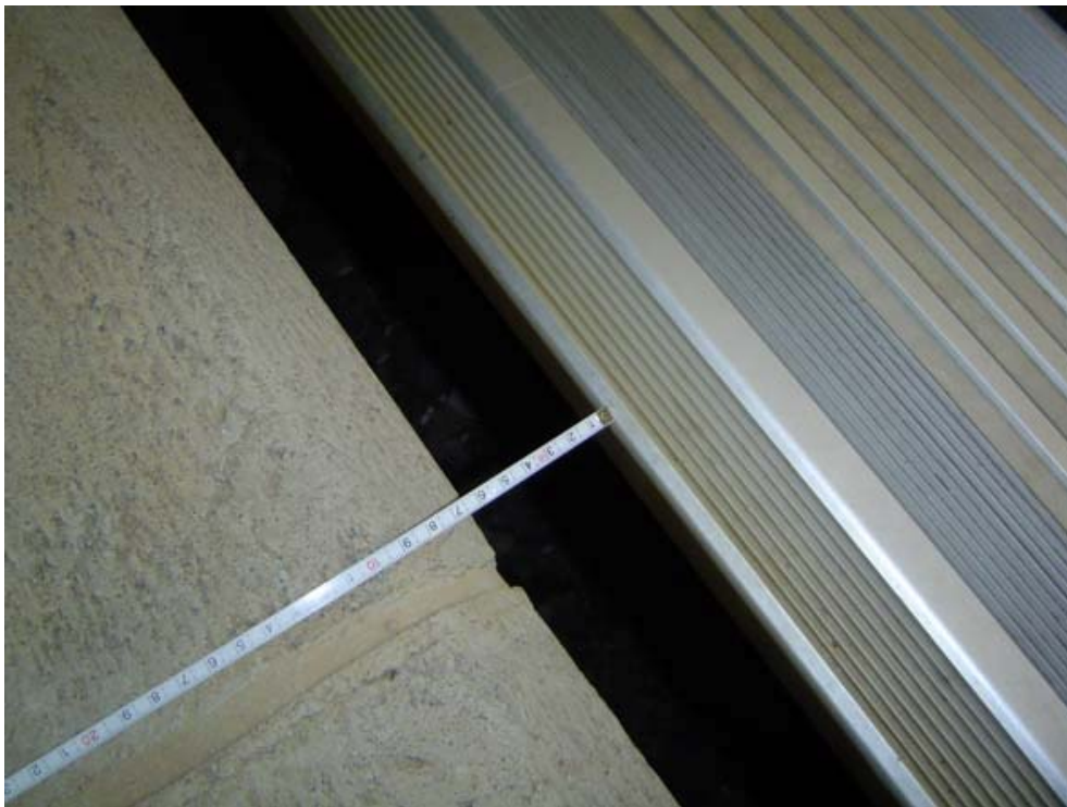
La distancia entre andén y plataforma extensible es de 6 cm, por lo que es muy sencillo que se bloquee la rueda, dificultando enormemente el acceso al tren CIVIA.
